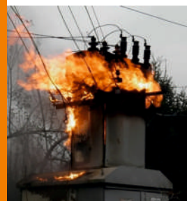
Перегрузка
