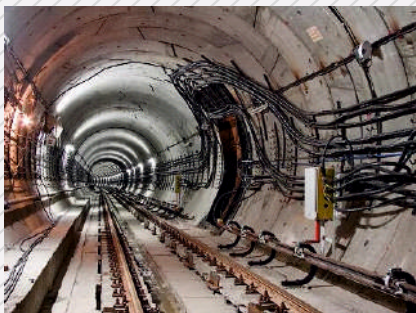
Подземные сооружения (тоннели)
