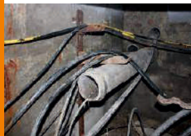
Перегрузка
